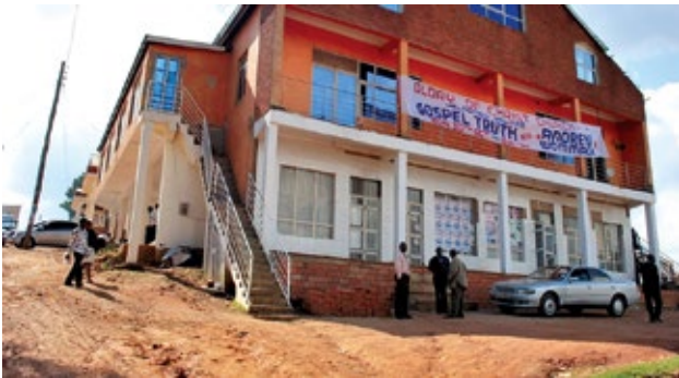
Die Parkplätze der Gemeinde werden asphaltiert.
